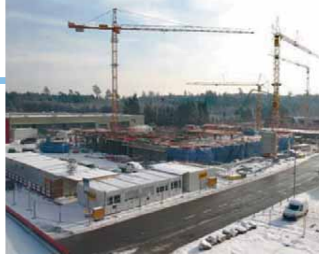
Baumaßnahmen am Hauptsitz der MBDA Deutschland.
